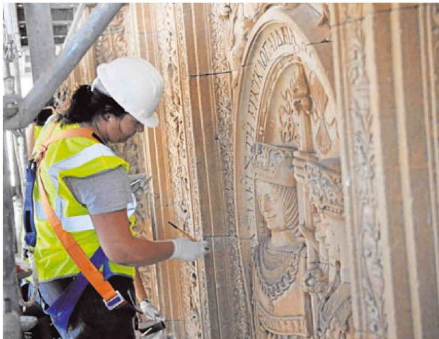
Un operario limpiando la portada del edificio histórico. | ARCHIVO
