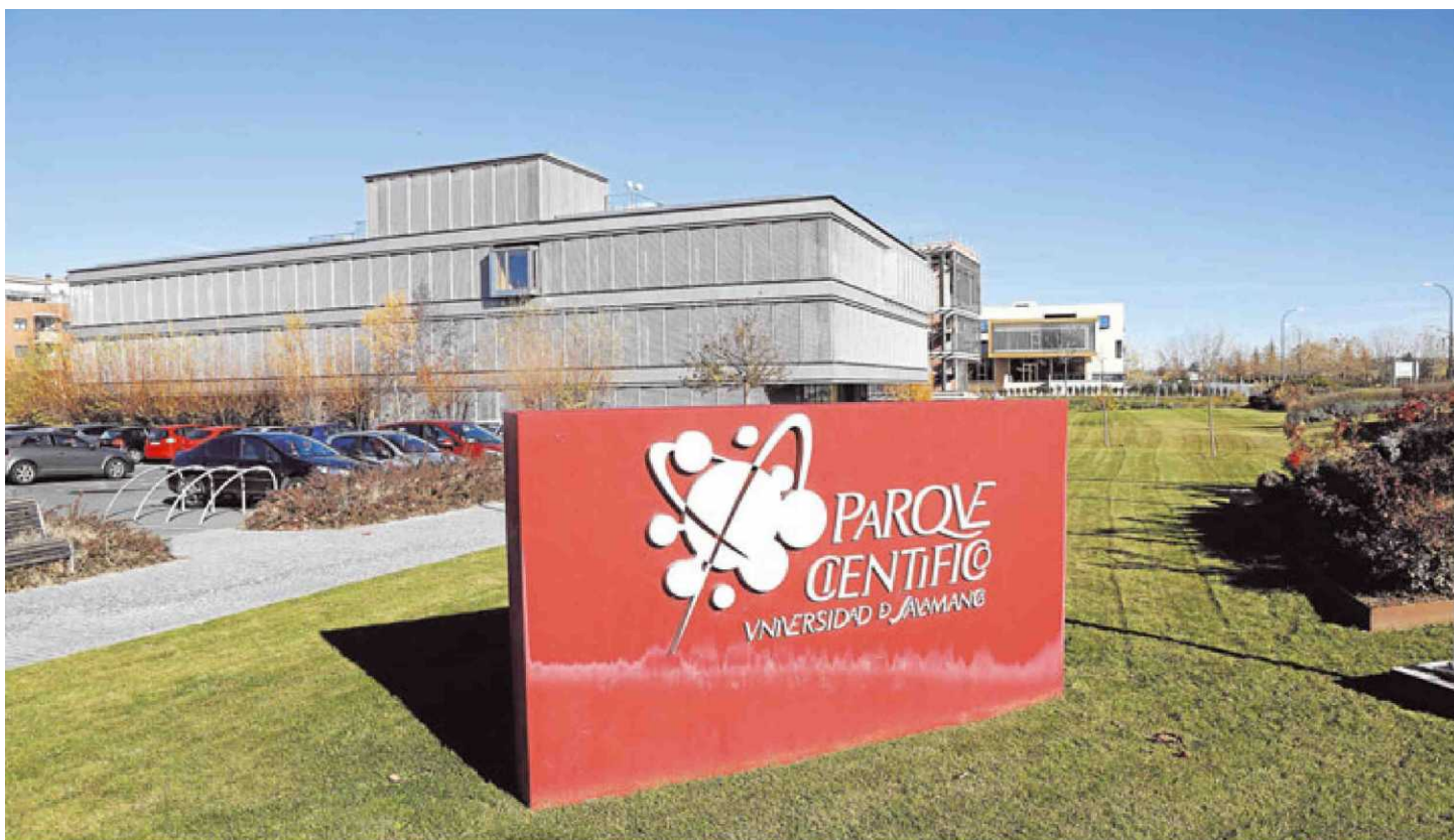
Edificios del Parque Científico de la Universidad de Salamanca ubicados en el término municipal de Villamayor. | ALMEIDA
