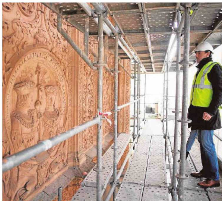
Uno de los trabajadores en el proyecto junto a la fachada
