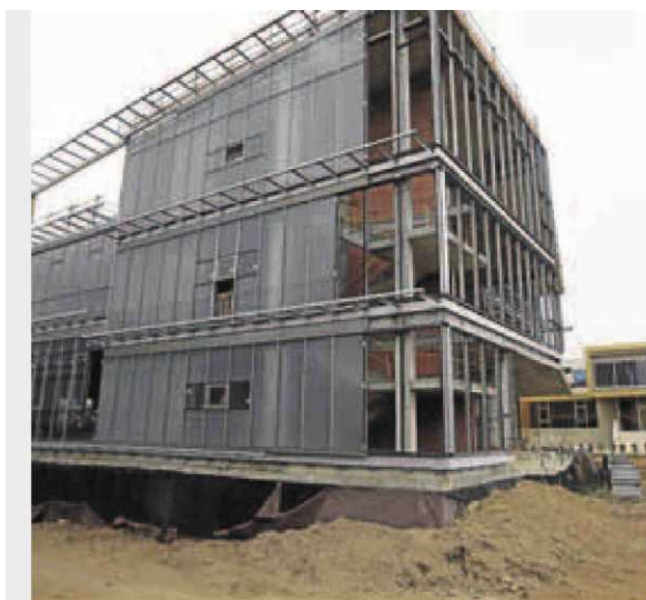
Vista exterior del edificio M4, en fase de construcción. :: WORD
