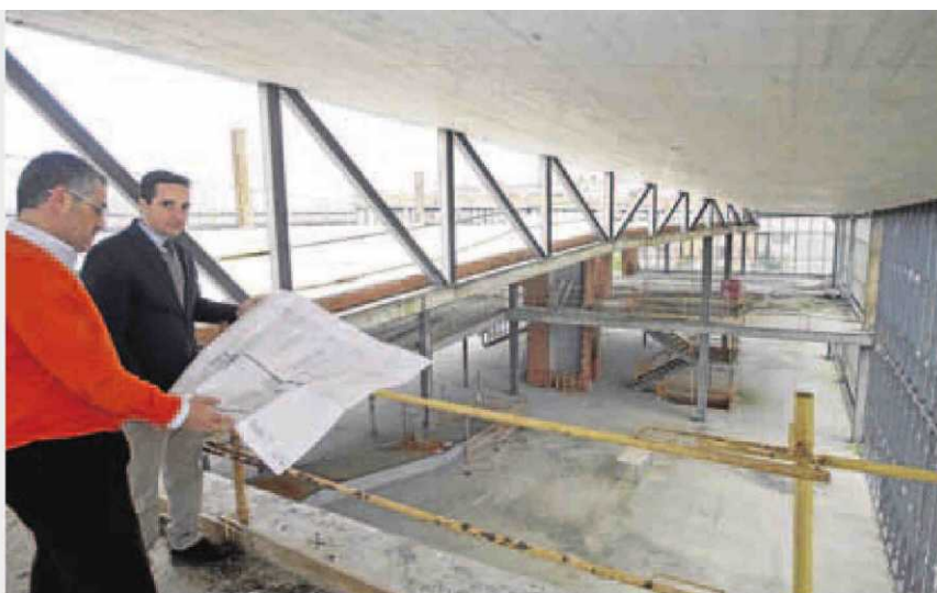
El vicerrector Juan Manuel Corchado supervisa las obras en el interior del inmueble. :: WORD
