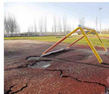
El suelo de la pista de atletismo agrietado.
