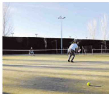
Deterioro de las pistas de tenis.
