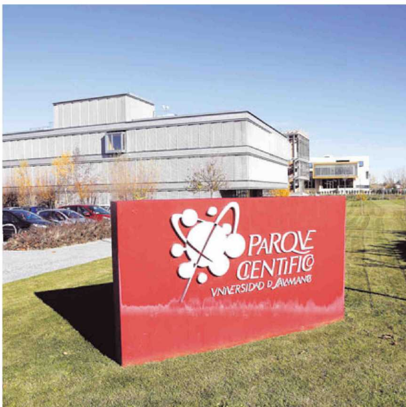
Exterior del espacio que acoge los edificios del Parque Científico de la Universidad en Villamayor.
