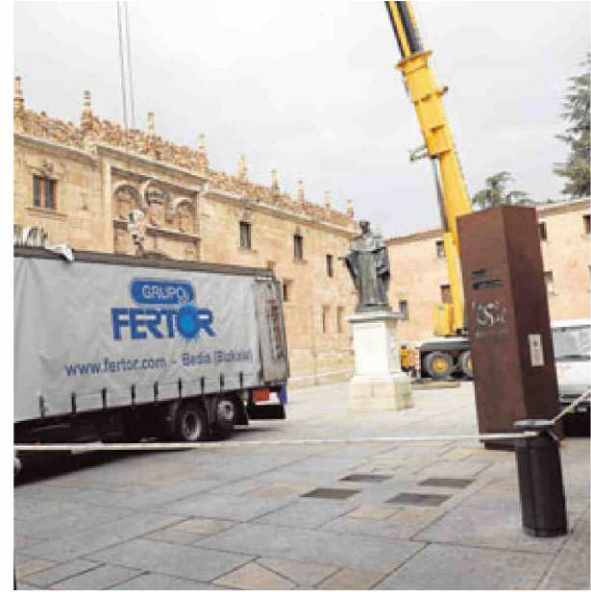
La gran grúa con la que se llevó a cabo el montaje de la obra.
