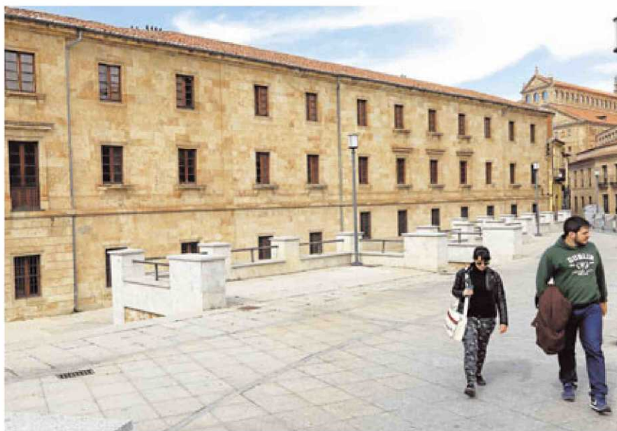
Edificio del colegio mayor de San Bartolomé, que se someterá a una reforma de 6,5 millones de euros. | ALMEIDA
