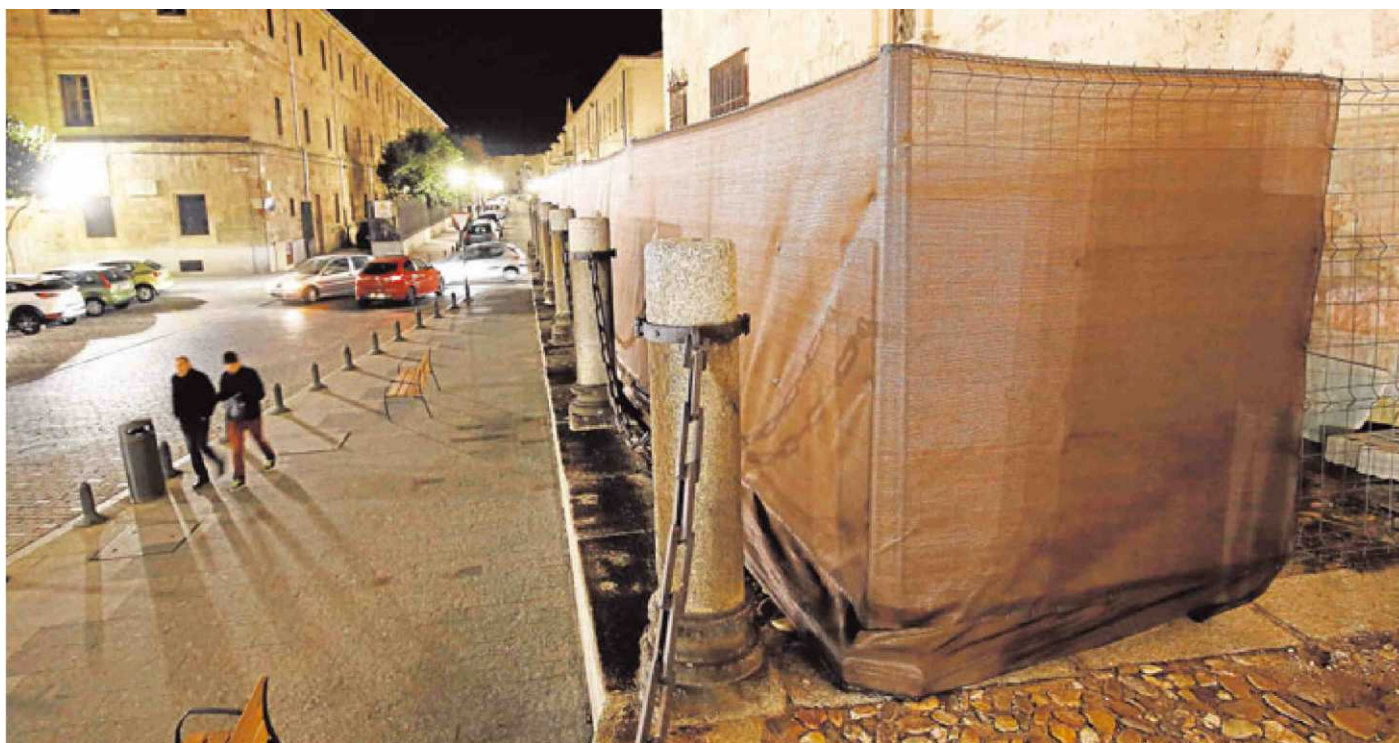
Los trabajos incluyen la demolición de parte del zócalo de la puerta de entrada para construir una rampa. | FOTOS: JAVIER CUESTA
