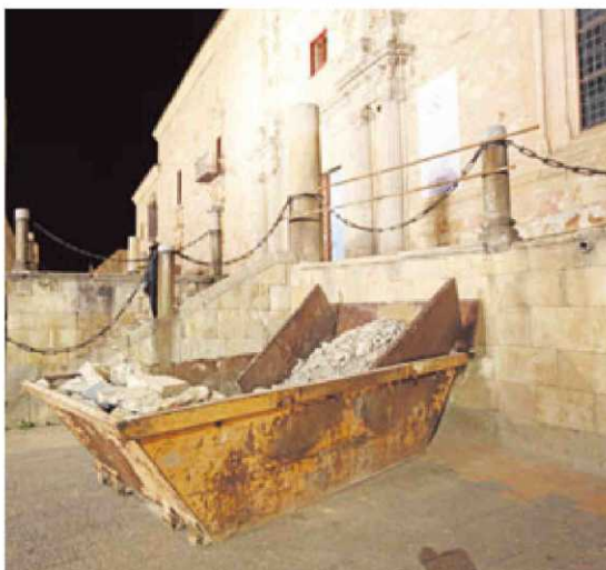
Un contenedor con los materiales retirados del Colegio Fonseca.
