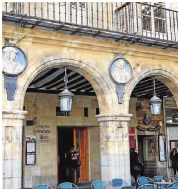
Pabellón de Petrineros, donde se colocará el medallón. :: LAYA
