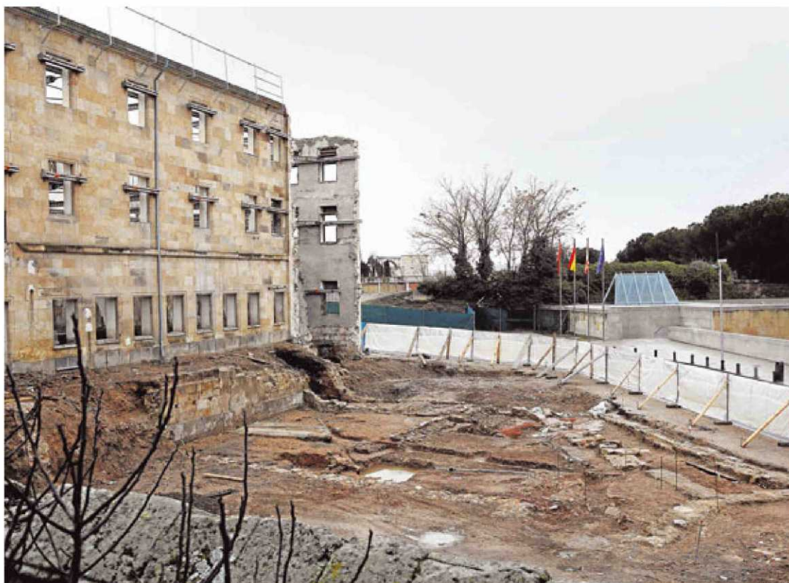
Excavación realizada junto al edificio del antiguo colegio mayor de San Bartolomé, en la Cuesta de Oviedo. | FOTOS: ALMEIDA
