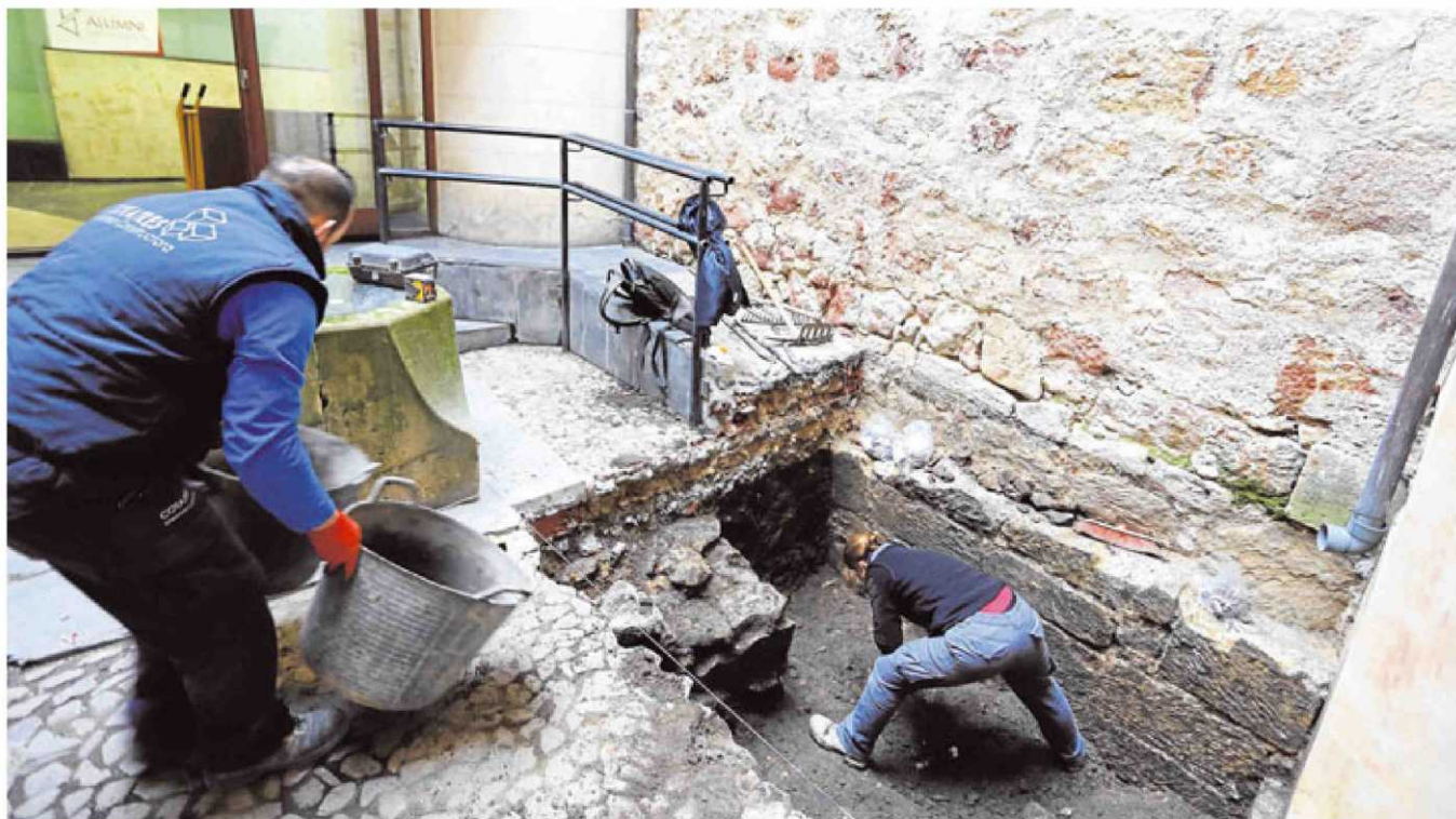
Trabajos en el foso para la instalación del ascensor en el edificio de las Escuelas Mayores de la Universidad de Salamanca. | ALMEIDA
