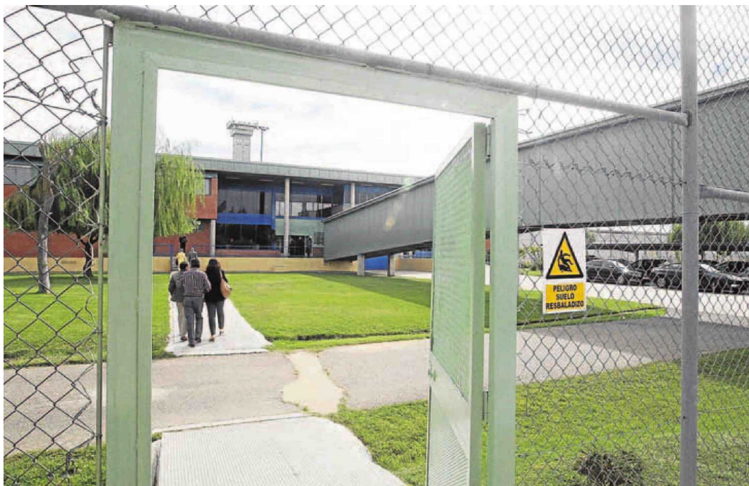
Vista exterior de las instalaciones de la prisión salmantina de Topas. :: WORD
