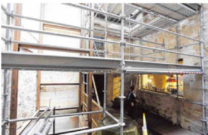
Estructura del futuro edificio de las Escuelas Mayores.
