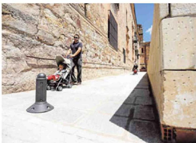
Nueva rampa para acceder al Colegio Fonseca. | FOTOS: ALMEIDA
