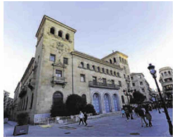
Vista exterior del antiguo inmueble del Banco de España. :: LAYA
