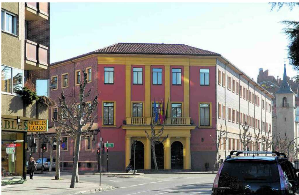
Vista exterior del Rectorado de la Universidad de León en la Avenida de la Facultad. :: L.N.C.
