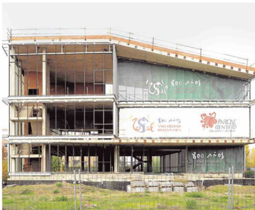
El edificio M4 del Parque Científico pendiente de finalizar.
