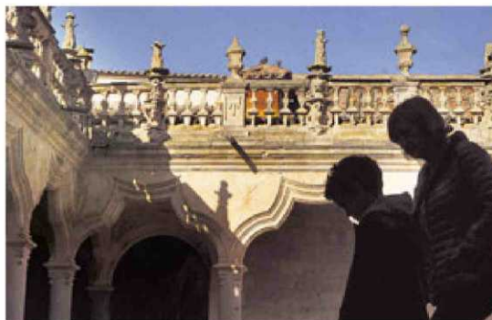
Crestería de las Escuelas Menores de la Universidad.
