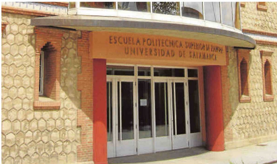
Fachada del edificio que alberga la Escuela Politécnica Superior de Zamora.
