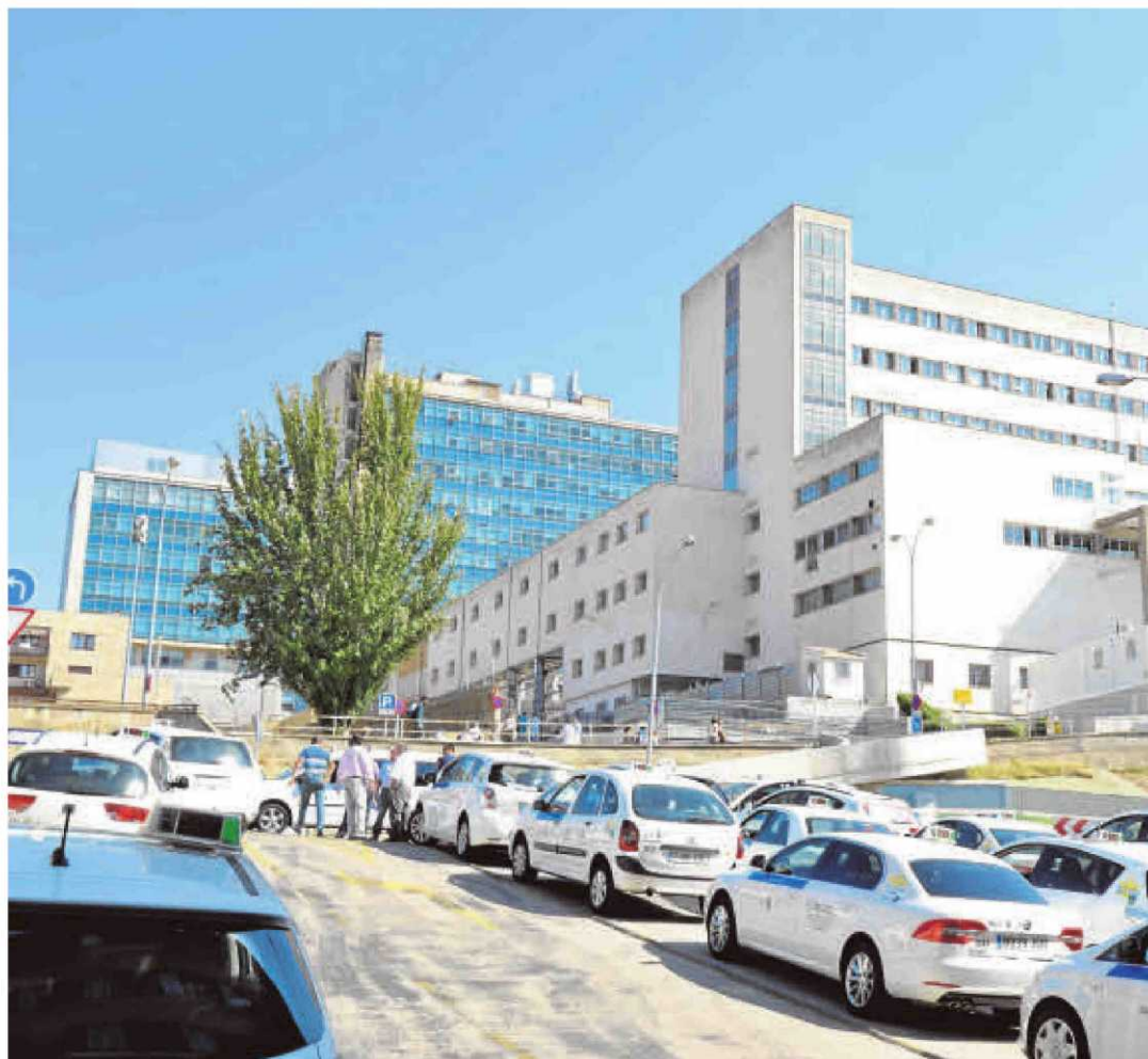
Edificio del Materno-Infantil, que quedará vacío cuando concluyan las obras del nuevo Hospital. | ARCHIVO
