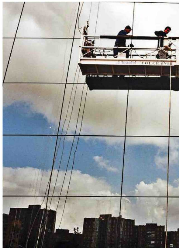
Un grupo de trabajadores limpia los cristales de un edificio de oficinas en la Comunidad. / FEDE
