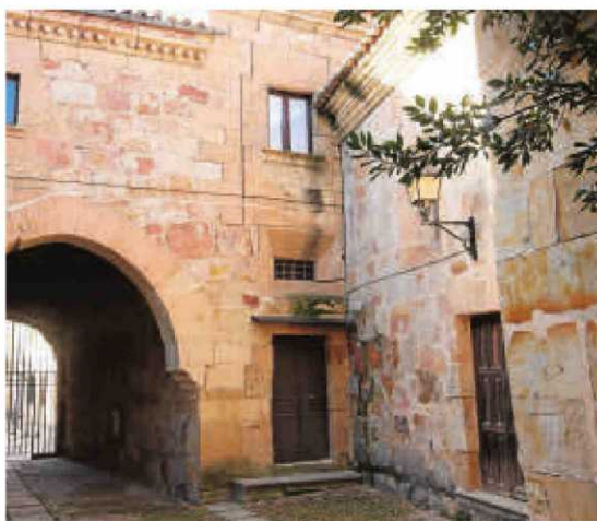
Exterior de la Casa del Conserje que forma parte de la rehabilitación.
