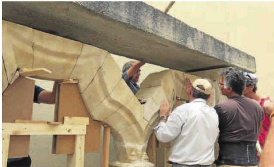
Imagen del proceso de instalación de los arcos de piedra de Villamayor. :: CHEMA SÁNCHEZ
