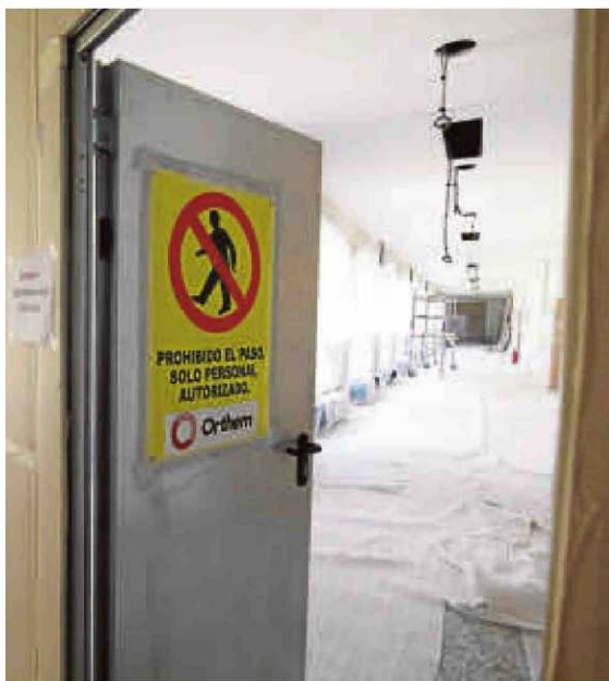
Obras en el interior de la Facultad de Psicología.
