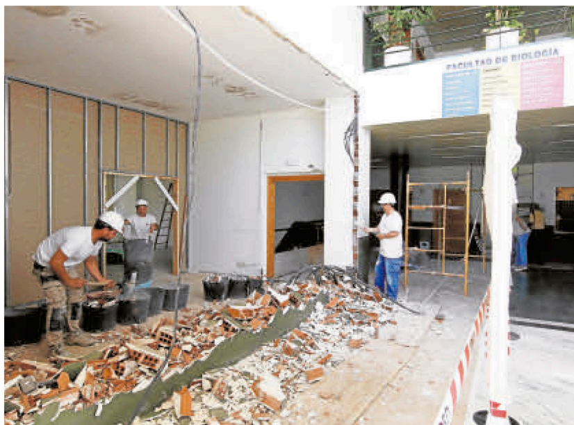
Obras en Biología para cambiar de ubicación la biblioteca. | FOTOS: ALMEIDA
