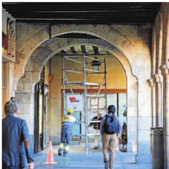
Trabajos de restauración en los soportales de la Plaza. :: LAYA
