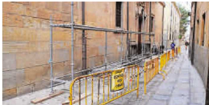
Cubiertas reparadas en la Casa-Museo Unamuno. Con la retira de los andamios, ha concluido la reparación de las cubiertas de la Casa-Museo Unamuno en la calle Libreros. La Universidad ha impulsado las obras. | CUESTA
