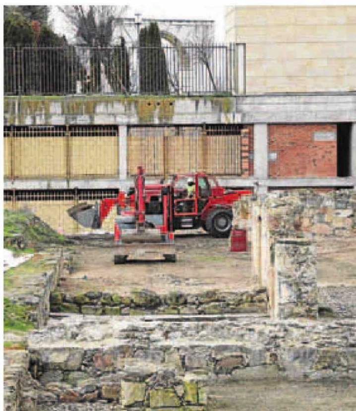
Trabajos de acondicionamiento en el Botánico. WORD
