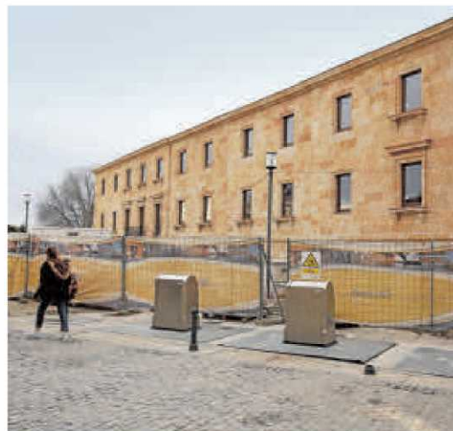
Imagen que presentan las obras en el edificio del antiguo “Bartolo”. | ALMEIDA
