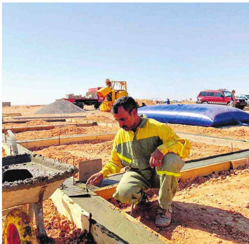
Construcción del hospital en Smara por parte de la ONG Acción Norte. | CEDIDA
