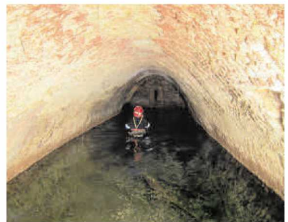
Un bombero inspeccionando las galerías inundadas del Pozo de la Nieve. | PMMU
