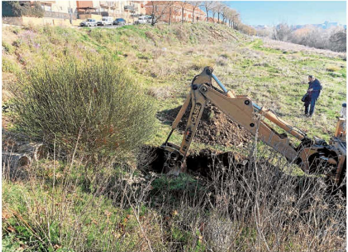
Uno de los sondeos realizados por el Ayuntamiento para localizar pozos, regatos y vaguadas, en este caso en el barrio de Huerta Otea. | PMJU
