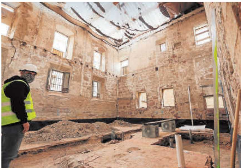
El interior de la casa del conserje completamente vacío.
