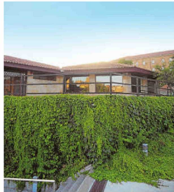
Exterior del edificio de Peñuelas donde se sitúa el gimnasio. | ALMEIDA
