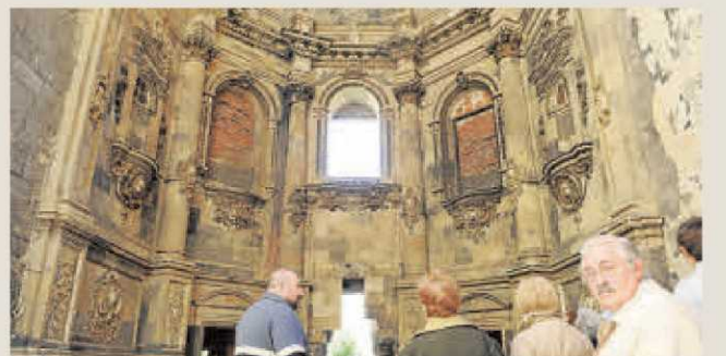
El ábside que se conserva de San Francisco
