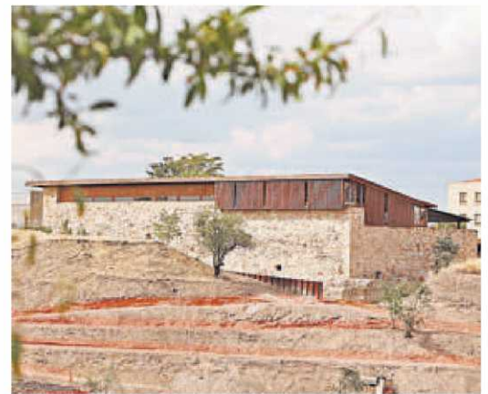
Edificio construido a principios de siglo en el Cerro de San Vicente. | ALMEIDA
