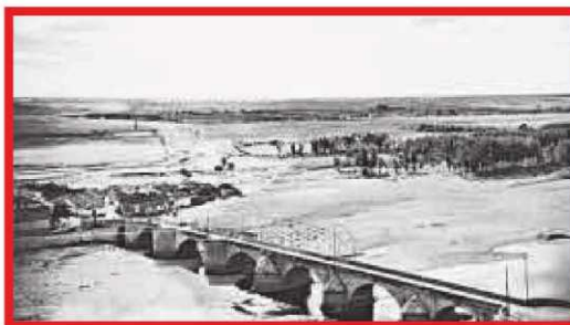
CIUDAD RODRIGO. Vista del Puente Mayor (Byne, 1915)
