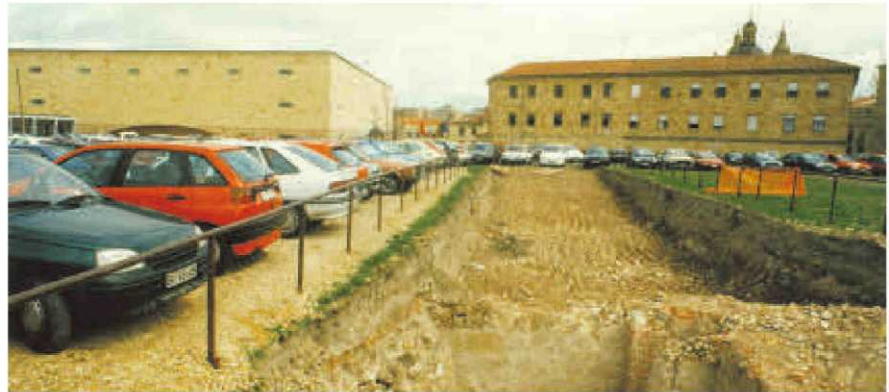
Coches aparcados en el Botánico cuando se construía el aparcamiento subterráneo.
