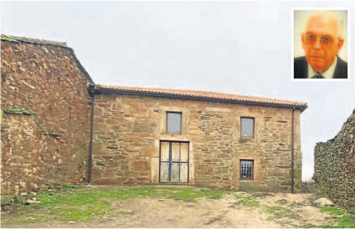
Edificio de la Casa del Maestro, que albergará el museo dedicado al creador de la Enciclopedia Álvarez (en el recuadro). AYUNTAMIENTO DE CEADEA DE ALISTE
