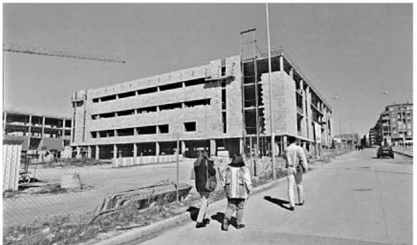
Construcción de la Facultad de Derecho.
