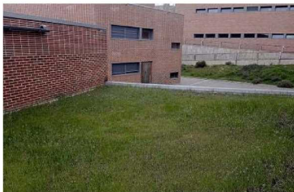
Cubierta donde se situará el proyecto de vegetación.
