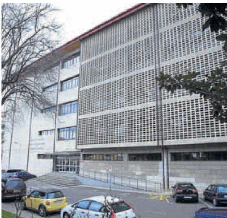
Edificio de la Escuela de Ingeniería. USAL
