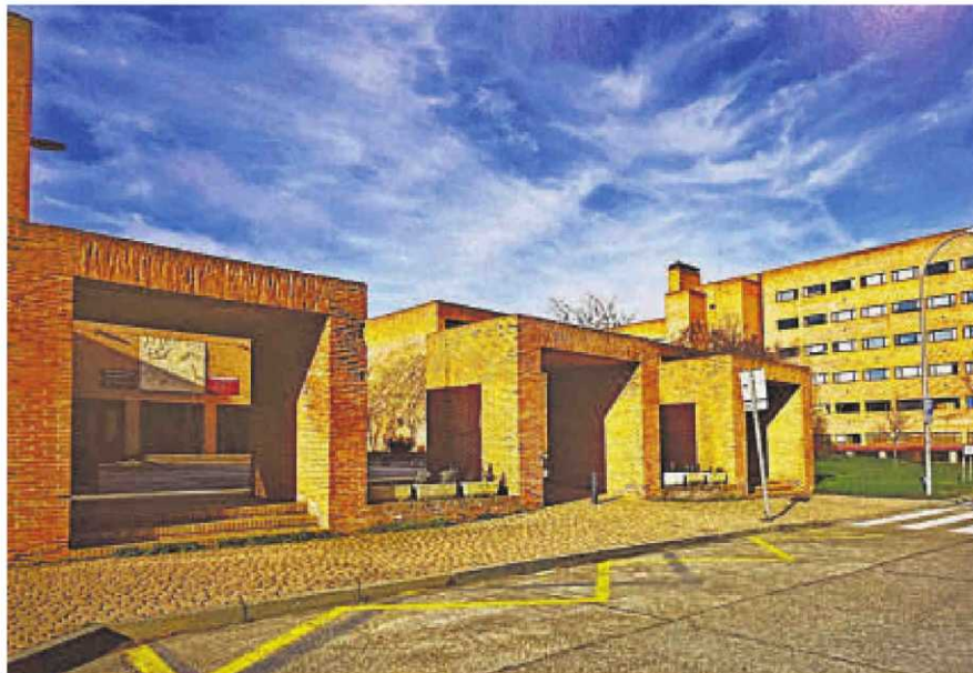
Fotografía de Vicente Sierra Puparelli de la fachada de la Facultad de Farmacia, primer edificio del Campus.
