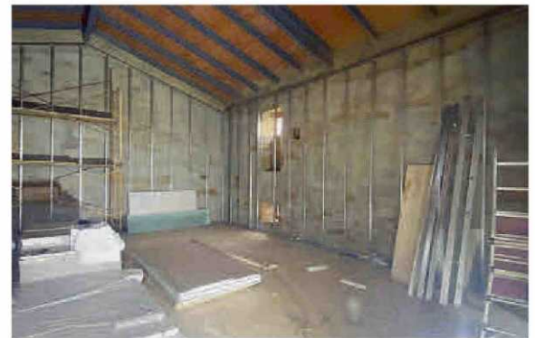
Obras de rehabilitación de las viejas escuelas de Ceadea, donde se instalará el Museo de la Enciclopedia Álvarez. | Ch. S.
