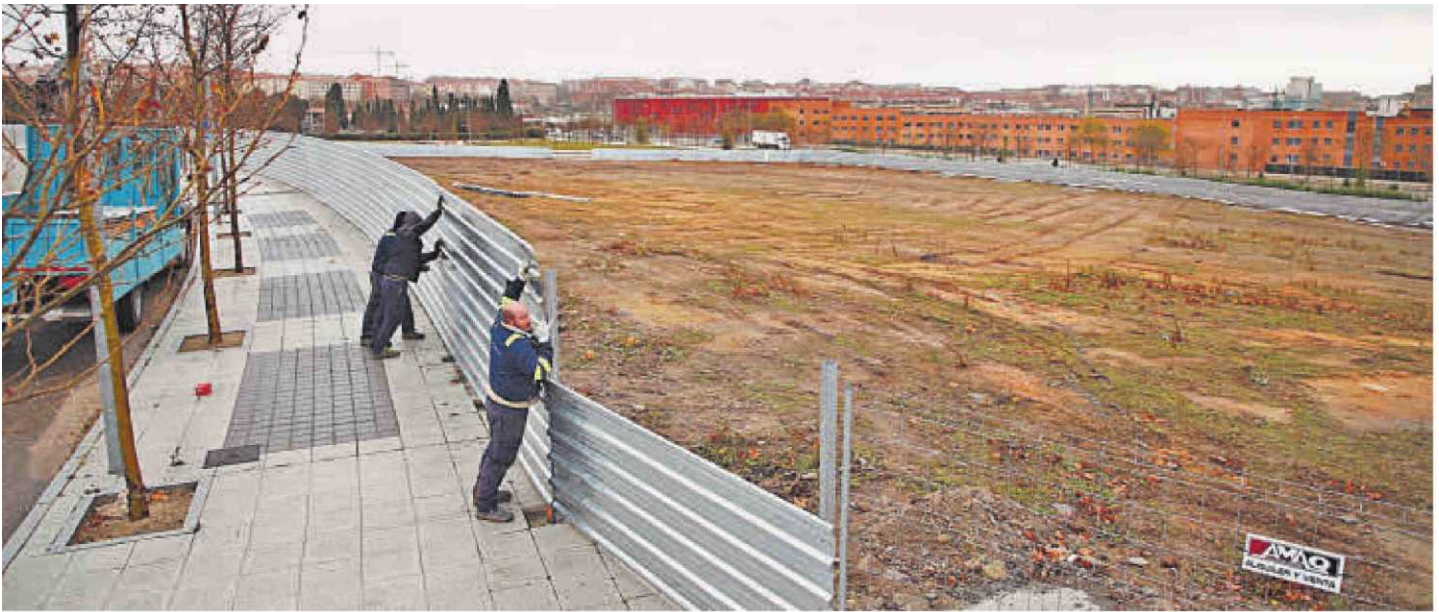
Operarios colocan vallas alrededor del solar donde se va a construir la Facultad de Ciencias Agrarias y Ambientales. | ALMEIDA
