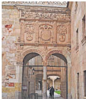
La portada exterior de acceso al patio.
