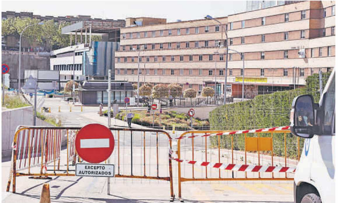
Varios operarios fueron cercando ayer el Clínico con vallas y mallas de ocultación, a pocos días de empezar el derribo. | FOTOS ALMEIDA
