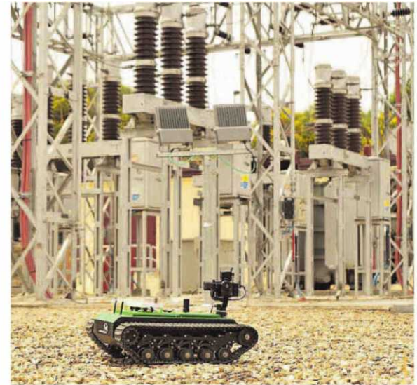
El robot durante su inspección en El Torrao. | Jose Luis Fernández
