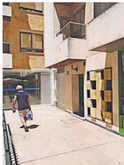
Fachada de Íscar Peyra 15 con piedras fosilizadas.
