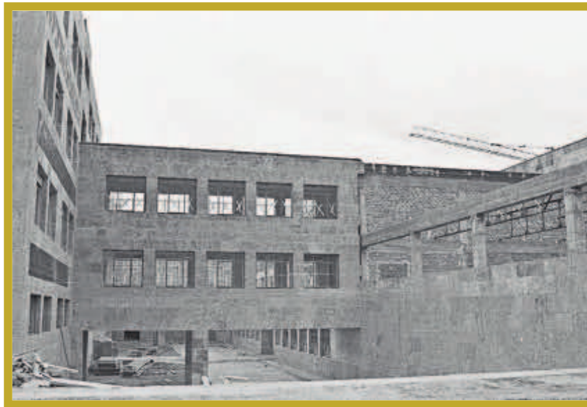
Construcción de la nueva Facultad de Ciencias, en una imagen de los fondos universitarios. | SALAMACAENELAYER.COM
