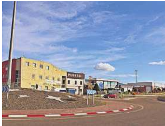
Polígono de Castellanos en el que se ubicará la planta de Novartis. EÑE
