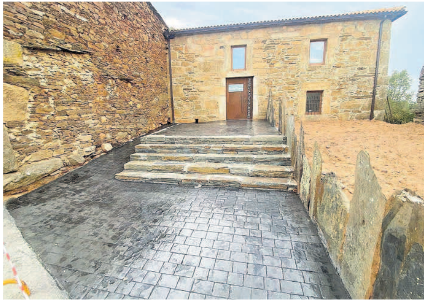
Aspecto exterior de la Casa del Maestro - Museo de Antonio Álvarez en Ceadea. | Ch. S.
